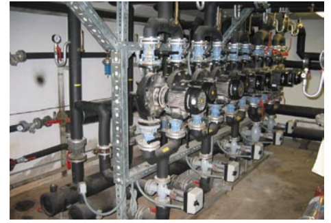
Slika 3: Sekundarni razvod v toplotni podpostaji TPPC
